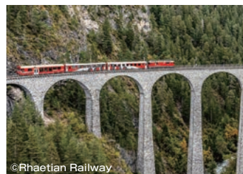
▲石造りの高架橋、ラントヴァッサー橋
